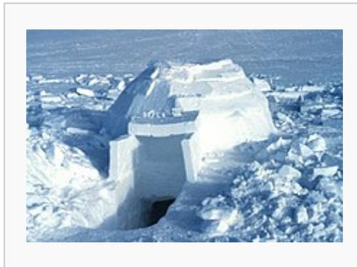
Un iglú de tamaño medio, casi completo, con excavación debajo de la puerta y el exterior sin terminar.
