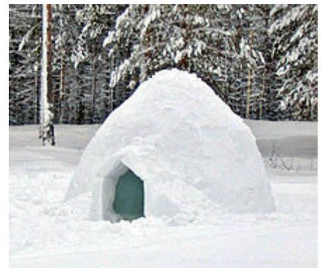
Iglú provisional (realmente, un quinzee) hecho en Finlandia. Nótese la construcción distinta de la puerta y la fragilidad evidente en la estructura.
