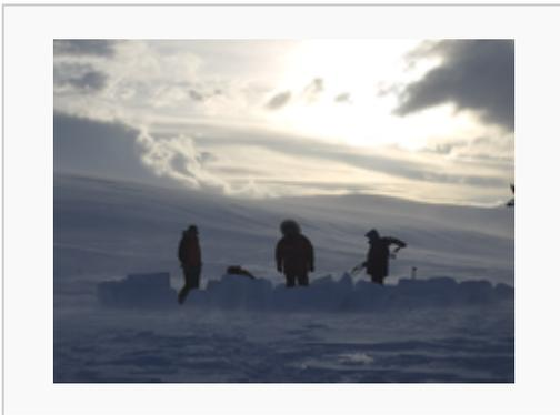
Proceso de construcción de un iglú a mitad de camino con método de ladrillos de nieve
